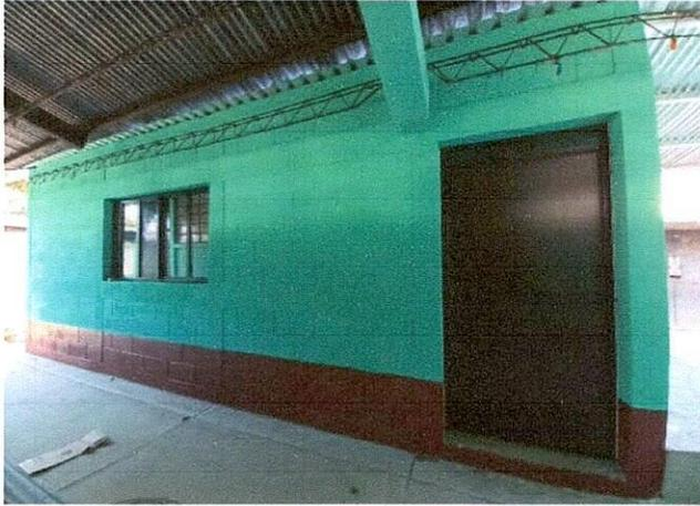
Foto1: Mejoramiento de Aula, levantado de 3 hiladas, ventanas y puerta.
